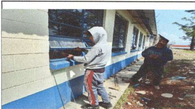
Foto 2: Colocacion de vidrios en las ventanas
