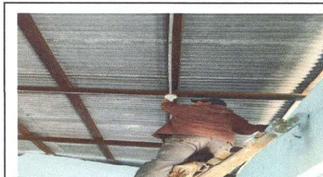
Foto 6: instalacion de sistema electrico
