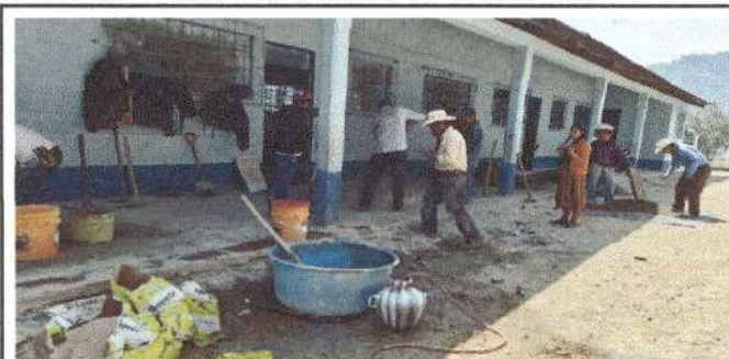
Foto 5: Arreglo de torta y colocacion de piso ceramico en el corredor de las aulas
