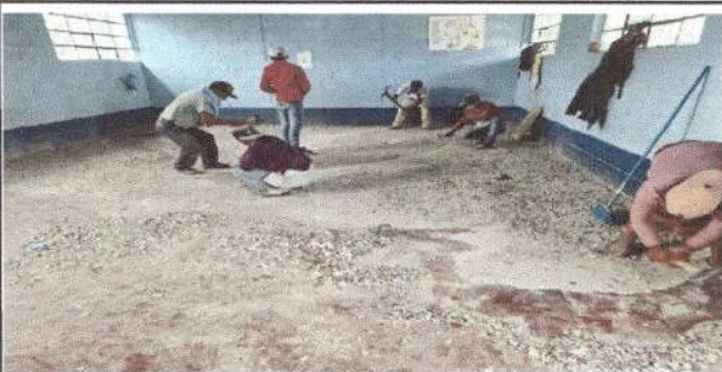
Foto 3: Trabajos realizados durante las sustitucion de piso ceramico en las aulas
