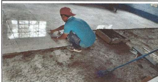
Foto 4: pegado de piso ceramico en aulas
